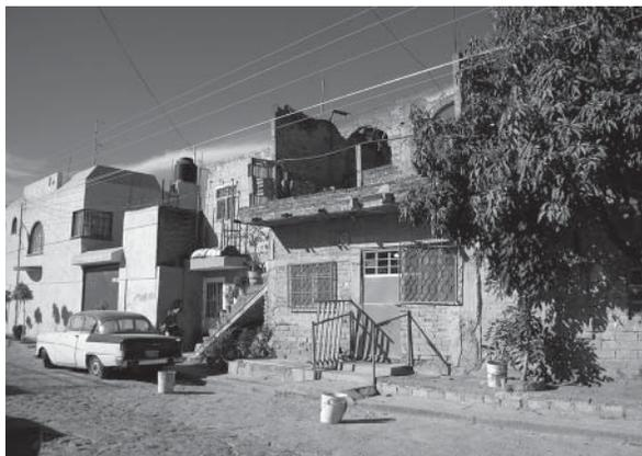
*Foto 5.7. Vivienda con una combinación de materiales temporales y permanentes (recámara con muros de tabicón y techo de lámina)*
